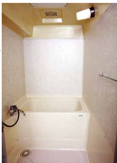
施工後 すっきりとした清潔な浴室に
