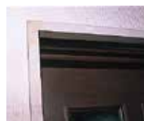
傷みの激しいドア枠を新しく
