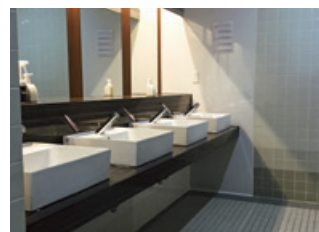
〈衛生設備工事〉
