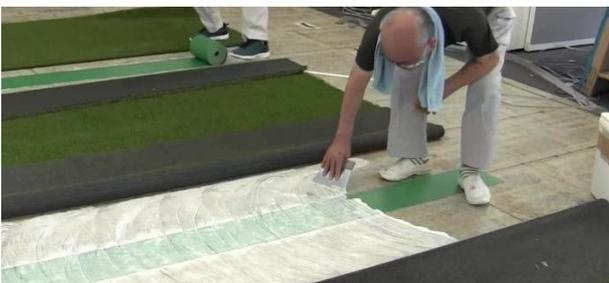
下地にジョイントテープを接着してから、人工芝の下地面に接着剤を塗布します。
