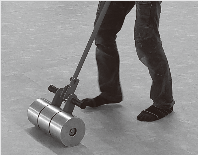
タイルローラーで貼り付け可能時間内にメラミントイル全面を入念に圧着してください。
