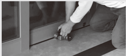
壁際等、力の掛かりにくい箇所は目地押さえ等を使用し十分に圧着してください。
