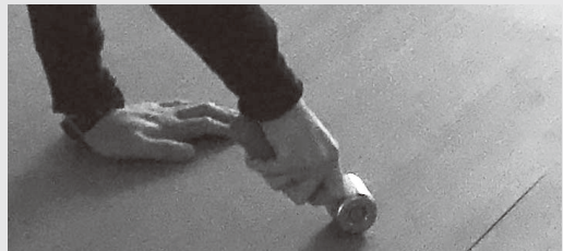
ハンドローラー等を用いて、メラミントイル床全体、端部や目地部などを圧着してください。
