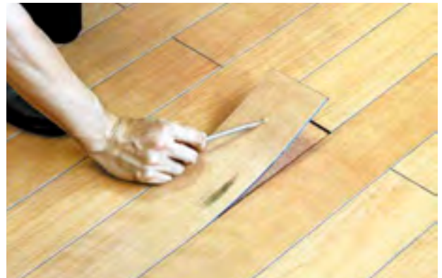
2 ビールアップボンドでの施工のため錐（キリ）等を使えば・・・
