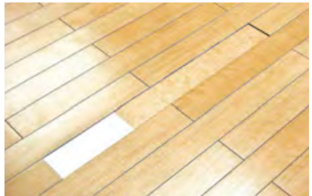
4 剥がした部分の下地には、接着剤がそのまま残っているので・・・
