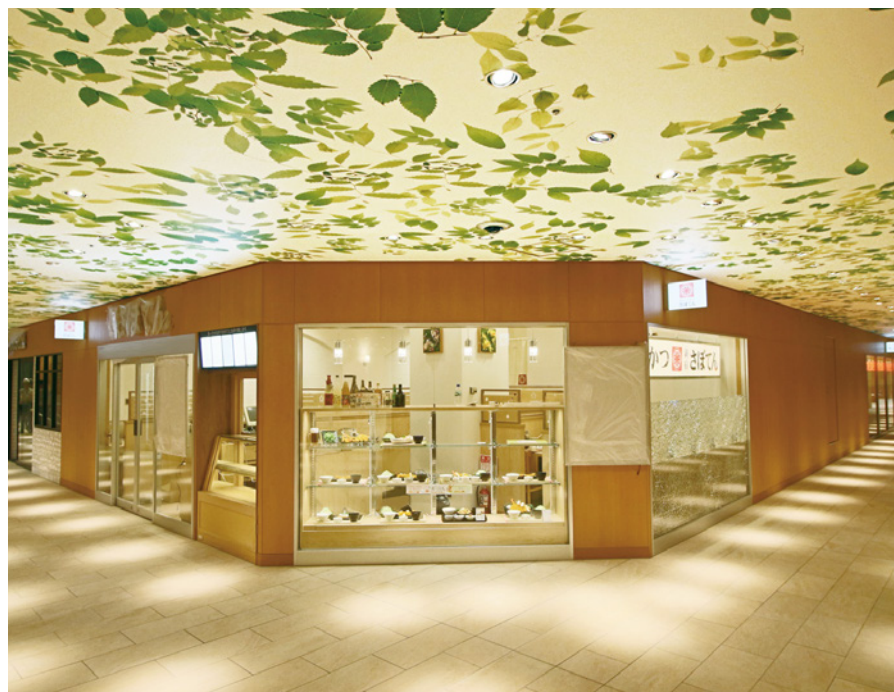
天井:インクジェット出力(オリジナルデータ)
