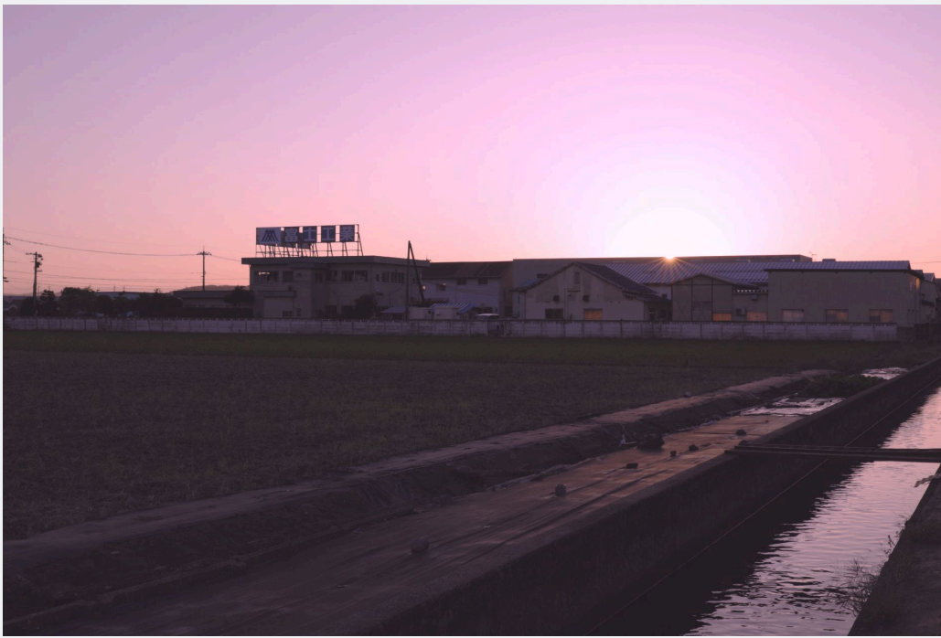
福井駅から車で南方面に15分。 北陸自動車道のすぐそばに建っている、富士工業さんの本社。
